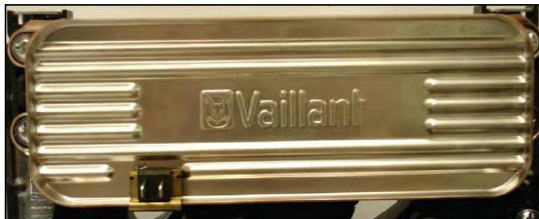
Вторичный теплообменник с NTC-датчиком (котлы серии plus)
