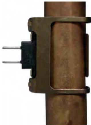
NTC-датчик, закрепленный на трубе с помощью зажима
